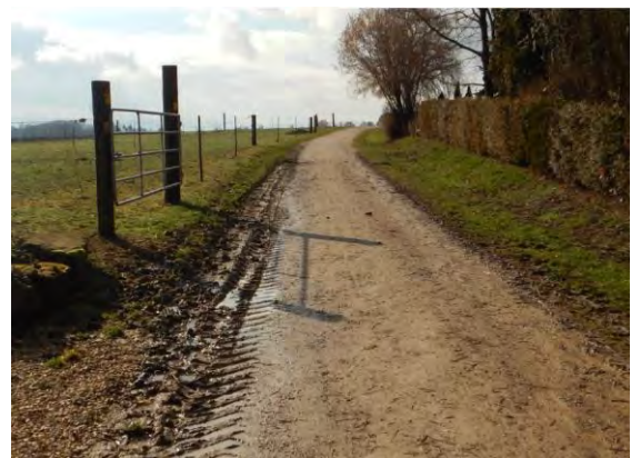
Abbildung 7: Verschmutzter Wirtschaftsweg im Landkreis Regensburg (Quelle: Eigene Aufnahme)
