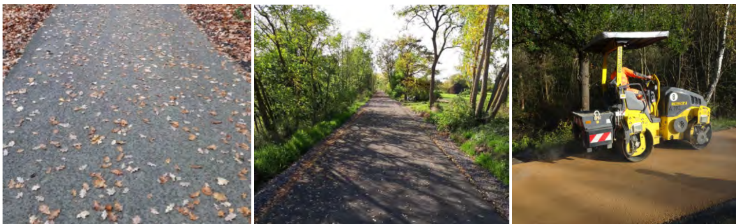
Abb. 2-3: Alternative asphaltähnliche Oberflächen aus Basaltstein und Spezialsanden (Quelle: BioSi Balastan®, Schweizer ideen-Werkstatt) / Abb. 4: Heller Split-Mastix-Asphalt
