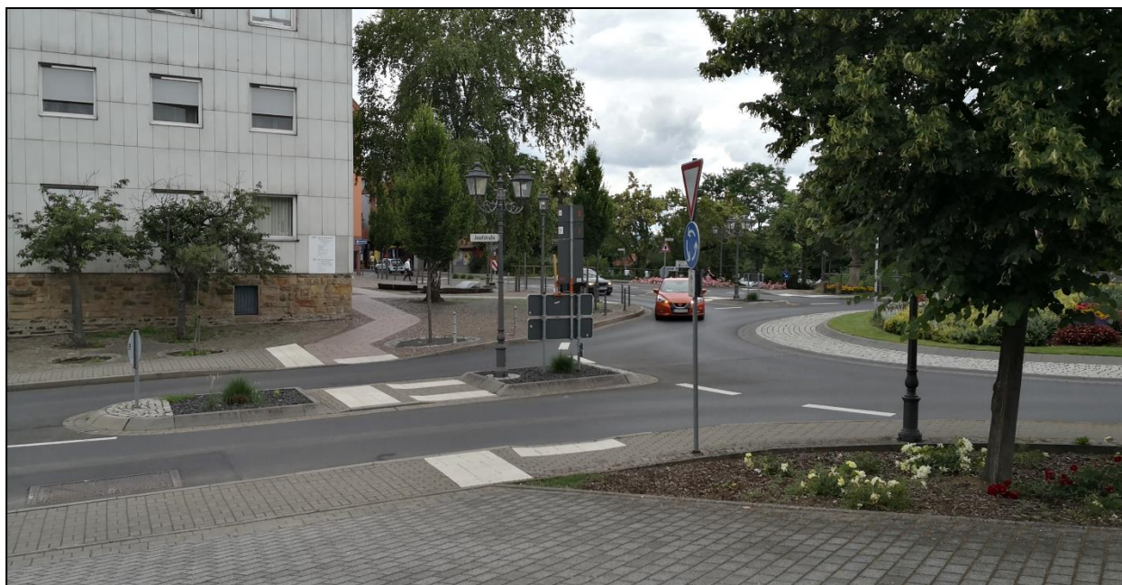
Abbildung 14: Fehlende Fußgängerüberwege Kreisverkehr Josefstraße / Großenbacher Tor
