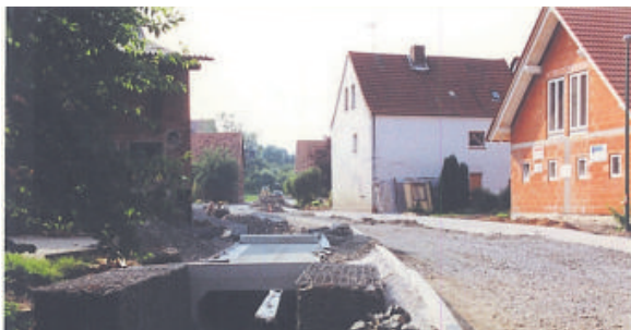
Ganz Dammersbach eine Baustelle: Die Ortskanalisation, die beiden Ortsstraßen und zahlreiche Anwohnerstraßen wurden seit Mitte der 90er Jahre erneuert.
