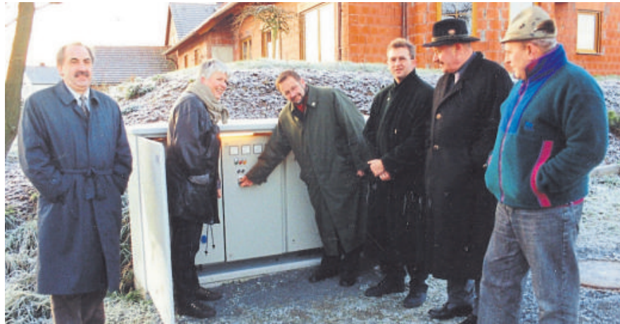
2000 wurde die Abwasserentsorgung in Dammersbach mit Rückhaltebecken in Betrieb genommen. Unser Bild zeigt Tiefbauingenieur Ewald Falkenhan, Ortsvorsteherin Martina Sauerbier, Bürgermeister Dr. Eberhard Fennel, Ersten Stadtrat Willi Vogt und den stellvertretenden Ortsvorsteher Oswald Walter
