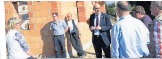
2015 wurde das Richtfest für das neue kleine Gemeinschaftshaus in Oberrombach gefeiert. Es wurde an das alte Backhaus angebaut.
