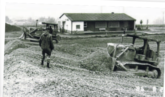
Mit Unterstützung der US-Patenkompanie der Stadt Hünfeld wurde der Ausweich-Fußballplatz in Sargenzell 1986 geschoben. Bald soll dort ein Bikepark entstehen.
