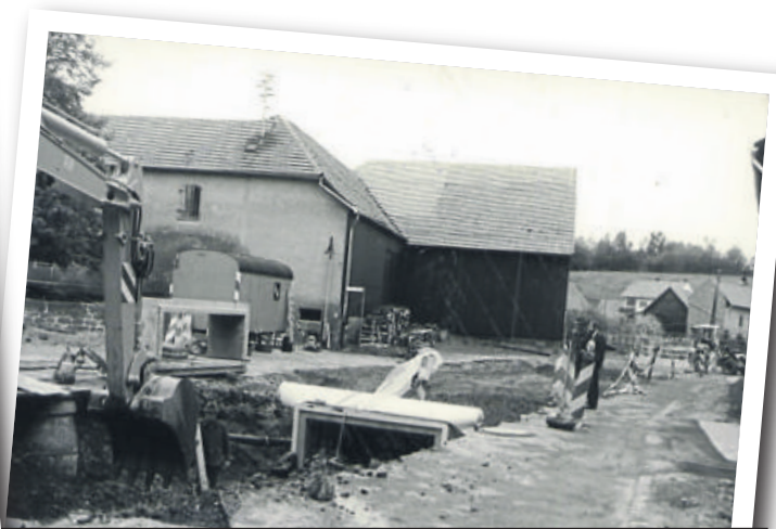
Eines der großen Sorgenkinder in der Dorferneuerung war die marode Verrohrung des Kalbachs mitten in der Ortslage. Hoher technischer und finanzieller Aufwand war erforderlich, die großformatigen Kastenprofile zu erneuern.
