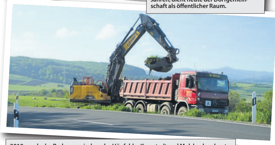
2019 wurde der Radweg zwischen der Hünfelder Kernstadt und Molzbach gebaut.
