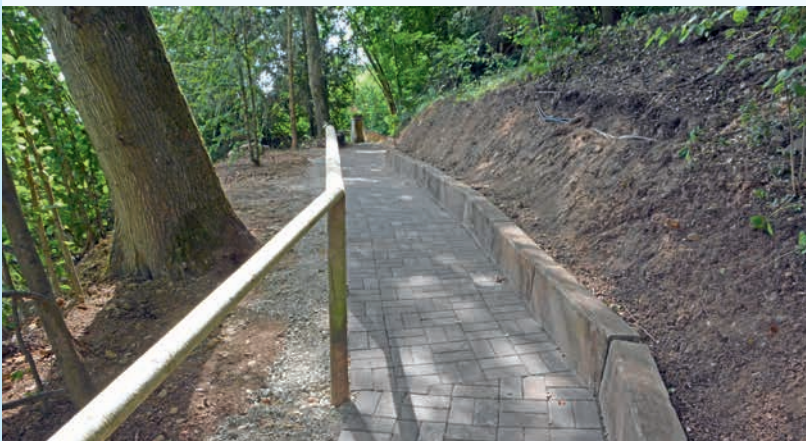
Initiiert durch die Hünfelder Kolpingfamilie wurde der Zuweg zur Mariengrotte erneuert.
