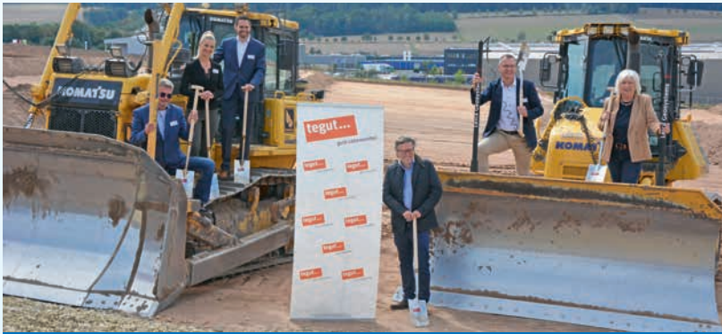
Beim offiziellen Startschuss zum Neubau des Tegut-Logistikzentrums (von links): Uwe Glück, (Prokurist Bickhardt Bau), Kathrin Wendt (Projektleiterin Tegut), Michael Egerer von der Geschäftsleitung Tegut, Michael Hohenhaus vom Generalplaner Tollé, Michael Möller (Projektleiter Tegut Bau) und Stadträtin Martina Sauerbier.
