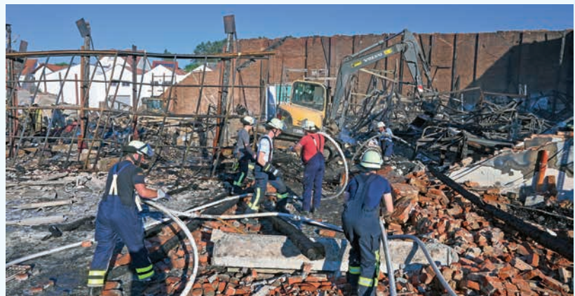
Beim Brand der Raiffeisen-Lagerhalle sind die Hünfelder Feuerwehren aus dem gesamten Stadtgebiet reihum täglich im Einsatz, um Brandwache zu halten und Glutnester zu bekämpfen.
