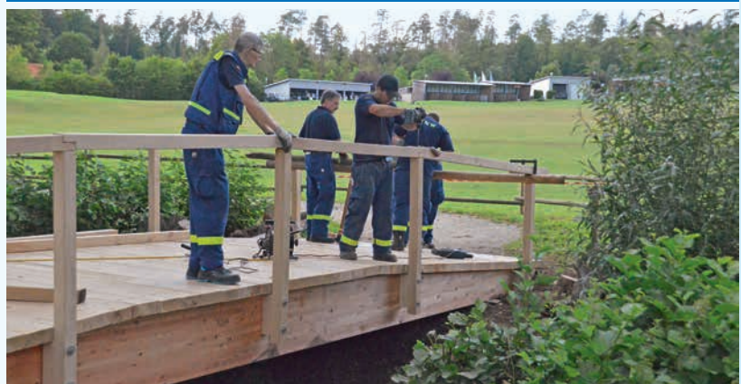
Die neue Brücke über den Ahlertsbach zwischen Golfplatz und Campingplatz in Hünfeld wird bei einer zweitägigen Übung der THW-Ortsvereinigung Hünfeld erneuert.
