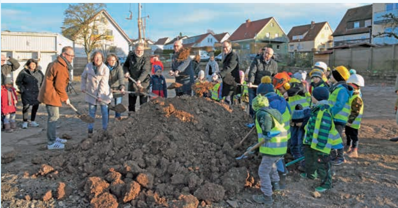
Mit tatkräftiger Unterstützung von Kindern aus dem Kindergarten St. Ulrich wird der erste Spatenstich für die neue Kindertagesstätte im Hünfelder Nord- und Ostend gesetzt.
