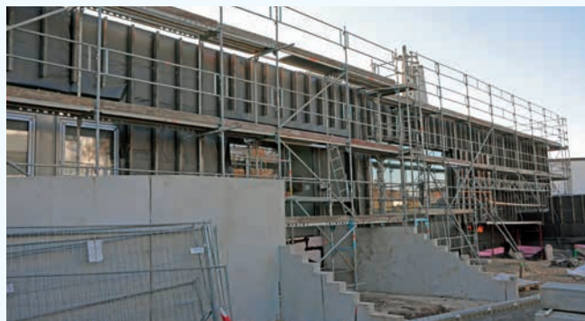
Die Bauarbeiten für den Neubau des Kindergartens Arche Noah im Hünfelder Nord- und Ostend sind in vollem Gange.
