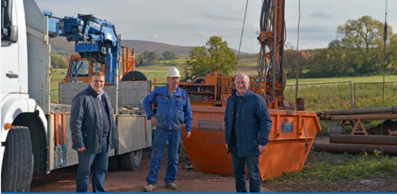
Die Stadtwerke wollen mit einer Erkundungsbohrung an der Nüst neue Trinkwasservorkommen erschließen. Mit dem Technischen Geschäftsführer der Stadtwerke, Gerhard Biensack (rechts), informiert sich Bürgermeister Benjamin Tschesnok (links) bei Brunnenmeister Rudi Hahn über den Fortschritt der Arbeiten.
