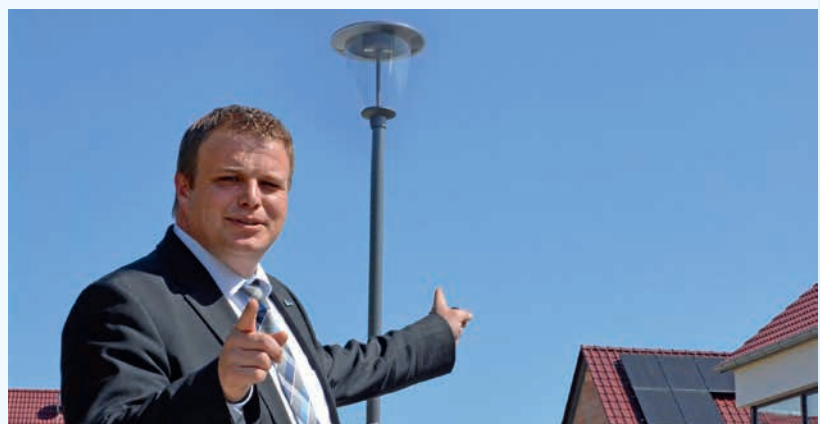
Weitere 1100 Straßenlaternen werden auf die umweltschonende LED-Technologie umgestellt.
