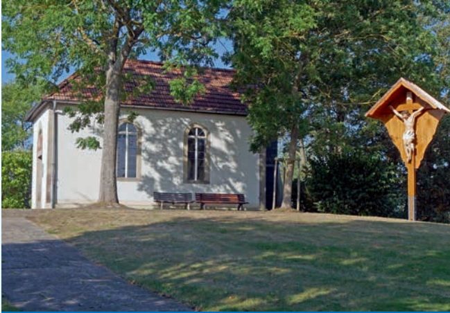
Das sogenannte Wirts-Kreuz in Großenbach findet nach der Restaurierung einen würdigen neuen Platz an der Lochkapelle. An den Kosten beteiligen sich die Interessengemeinschaft (IG) Gefallenen-Kapelle Großenbach, die Stadt Hünfeld, das Bischöfliche Generalvikariat und der Landkreis Fulda.
