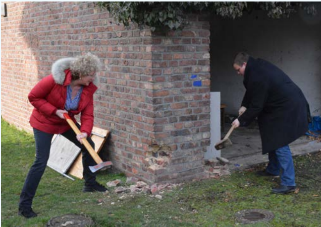
Kräftig den Hammer schwingen Ortsvorsteherin Pia Biedenbach und Bürgermeister Benjamin Tschesnok zum Auftakt der Bauarbeiten zum Anbau an das Kombinationsgebäude Sargenzell. Zuvor muss das alte Nebengebäude abgerissen werden.
