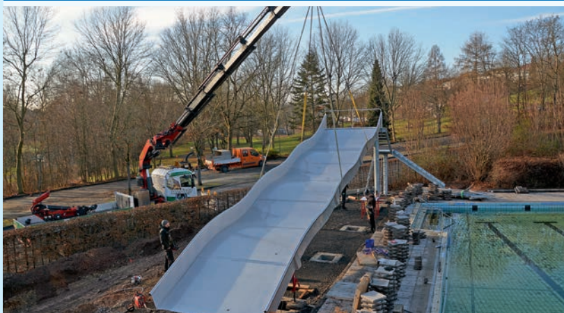
Die neue Breitwellenrutsche im Hünfelder Freibad wird für die kommende Freibadsaison aufgebaut.
