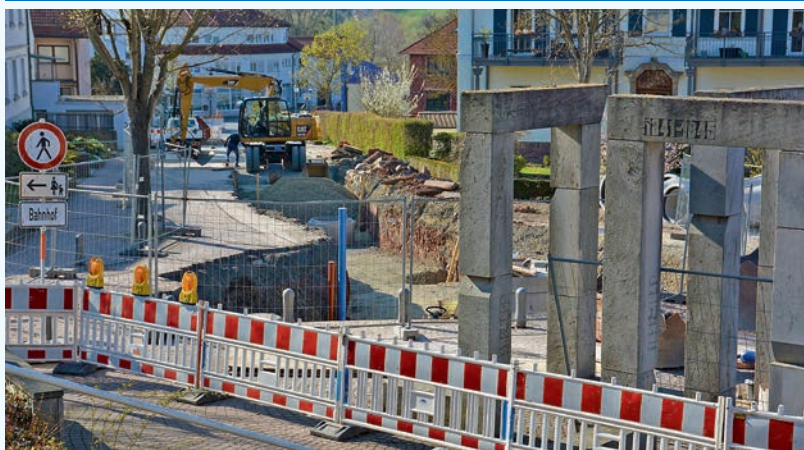
Eine Großbaustelle gibt es in der Klingelstraße. Umfangreiche Arbeiten müssen vorgenommen werden.
