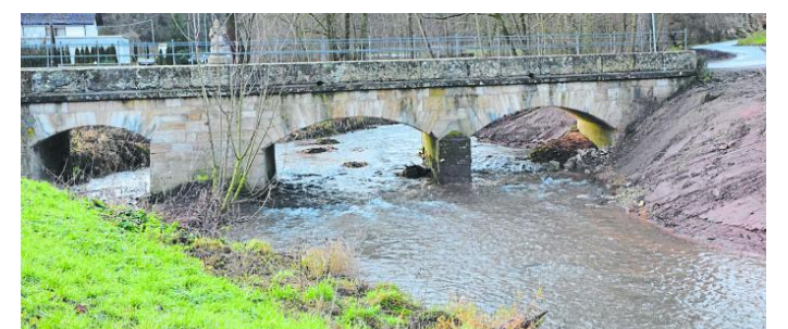
Das Flussbett der Nüst unterhalb der Barockbrücke in Mackenzell wurde neu profiliert, um einen besseren Hochwasserabfluss zu gewährleisten. Dabei wurden auch Anlandungen beseitigt.
